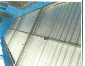
Foto 6: Proceso de instalación eléctrica
